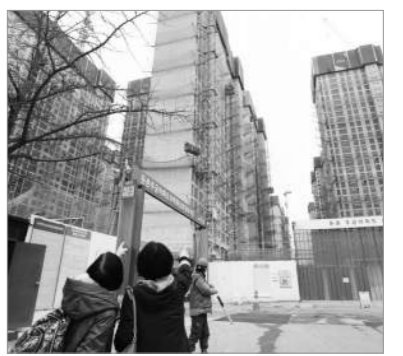
서울 강동구 둔촌주공 재건축 공사 현장 모습. @뉴스시스
